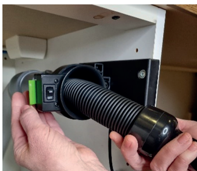
Geben Sie den Schlauch frei, indem Sie den Arretierhebel von sich wegdrücken.
