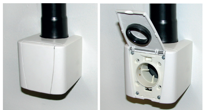
Bild 10. ein spezieller aufputz-Montagerahmen (Zubehör) wird in diesem Fall verwendet. dieser Rahmen wird als erstes an der Wand befestigt, danach wird der scharfe einlassbogen mit fortführendem Rohr in diesen Montagerahmen eingebracht. nach einlegen der Steuerleitung wird der Saugdosenoberteil auf diesen Rahmen befestigt.
